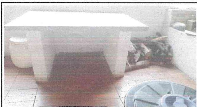
Foto 11: Mueble de concreto para implementar el azulejo
