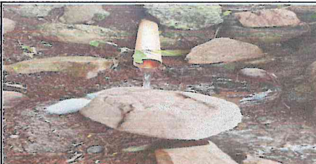
Foto 6: Sustitución de tubería de pvc de aguas negras las cuales salen al patio de la Escuela ocasionando mal olor
